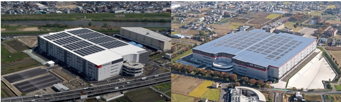
自家消費型太陽光発電所が稼働済のレッドウッド藤井寺DC(左)とESR久喜DC (右)
